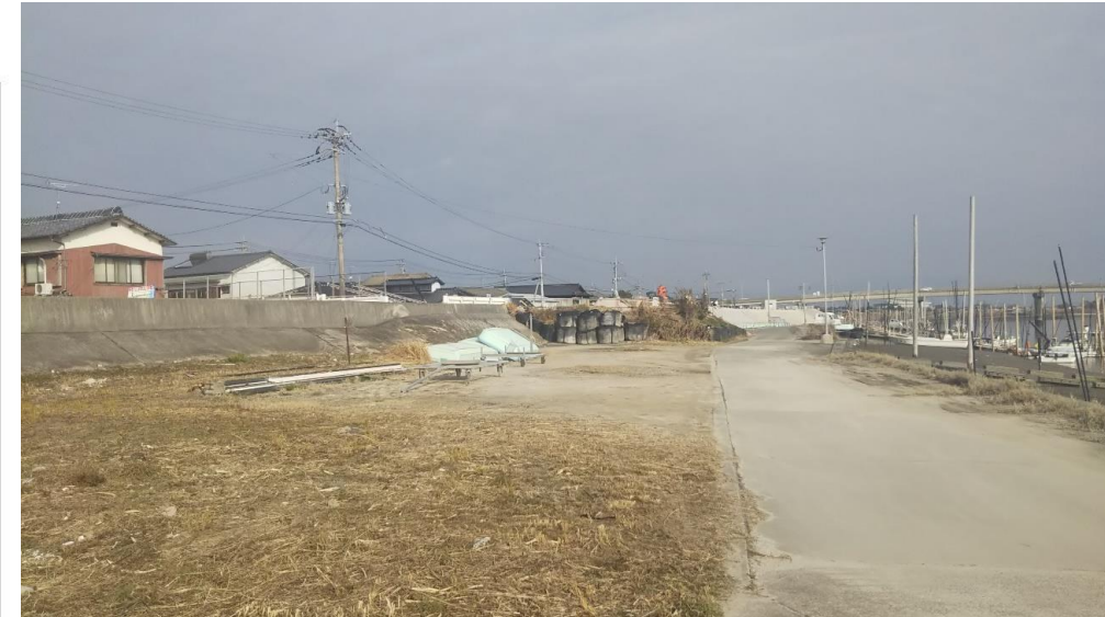
写真：所有者不明土地（左手前）のために河川整備事業が中断した事例（筑後川水系早津江川）（2019年1月、発表者撮影）
